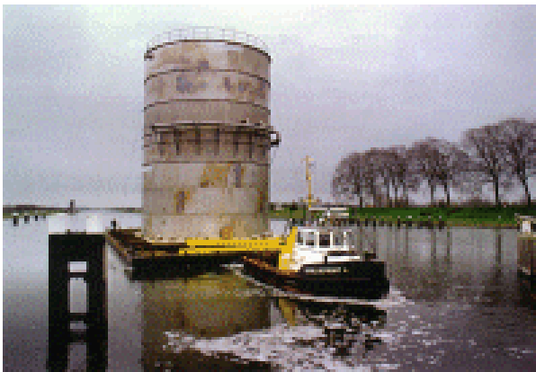
Foto 1: Eén van de grootste gelaste constructies in massief titaan gefabriceerd door Exotech BV te Vlissingen op weg naar z'n eindbestemming. Afmetingen opslagtank: diameter 11.260 mm, hoogte 15.500 mm, wanddikte 10-5 mm.
